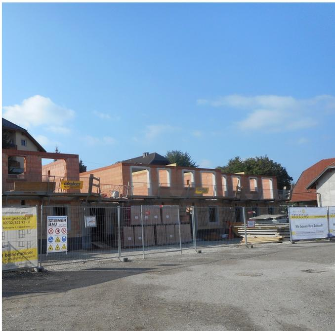
Auf den Grundstücken 201/3 und 201/5 wird je ein Kleinwohnhaus errichtet. Beide Häuser beinhalten je 4 Reihenhäuser. Jedes Reihenhaus wird über das Kellergeschoß erschlossen, welches neben Windfang und Vorraum je noch ein Zimmer sowie einen Kellerraum, in welchem die Haustechnik untergebracht ist, beinhaltet.
